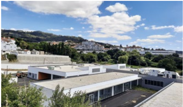
Sever do Vouga, Centro Escolar de Sever do Vouga
