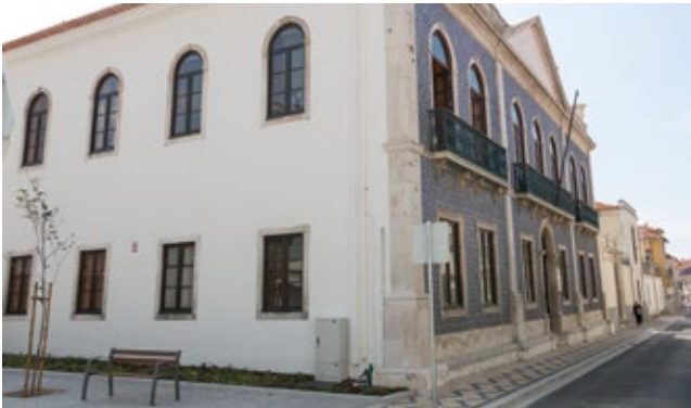
Sede da CIRA, Rua do Carmo (obra CMA)
