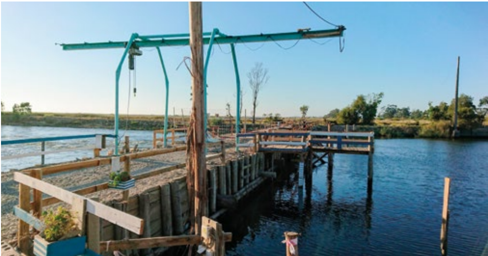
Atual Açude provisório
