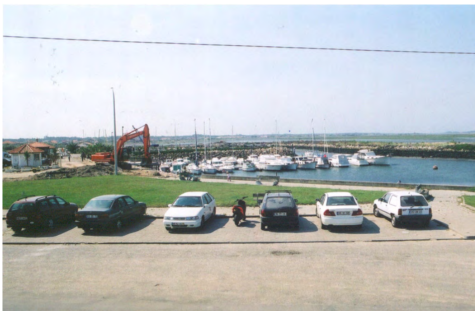
Vista geral da instalação
