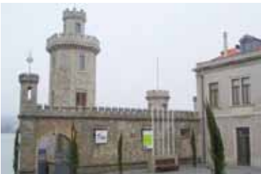
Albergaria-a-Velha Biblioteca Municipal
