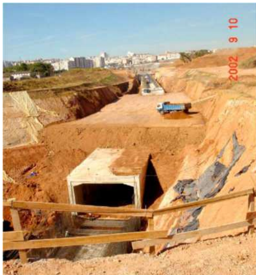
Figura 33 – Revestimento definitivo de túneis construídos a “céu-aberto
