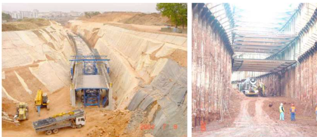
Figura 32 – Construção de túneis a “céu-aberto”
