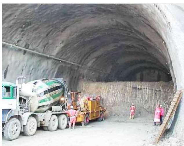
Figura 34 – Método de escavação NATM
