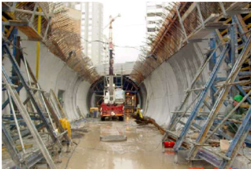
Figura 33 – Revestimento definitivo de túneis construídos a “céu-aberto
