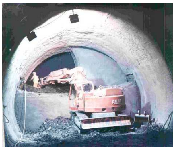
Figura 34 – Método de escavação NATM
