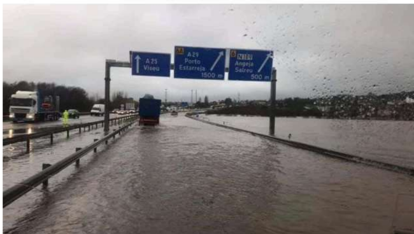
Figura 177 - Danos causados pelas inundações de 2019 98
