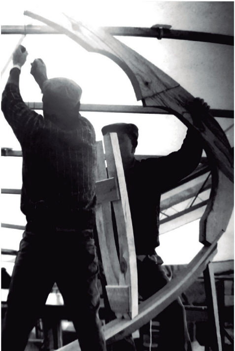
Da esquerda para a direita: Fixação caverna e fixação da bica da ré 2004 ©Michael Bry - cedidas por CM Sever do Vouga
